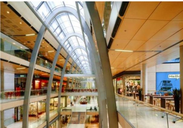
**Abb. 11:** Die 30.000 m<sup>2</sup> der 2009 fertiggestellten Europa Passage in Hamburg bieten Platz für 120 Geschäfte. Oberhalb der Passage befinden sich Büroflächen. Die markanten Stahlkonstruktionen der Passage werden durch eine F90-Brandschutzbeschichtung auf Lösemittelbasis geschützt.
