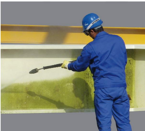
**Abb. 16:** Verschmutzte Brandschutzbeschichtungen lassen sich durch Abblasen, Absaugen oder leichtes Abbürsten reinigen. Einige Beschichtungen können sogar mit dem Hochdruckreiniger gesäubert werden.
